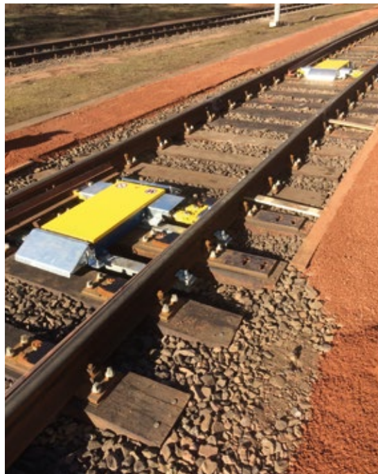
Weichenantrieb WA 160i-V im Einsatz bei SHS Saarstahl in Dillingen. Point Machine WA 160i-V in use at SHS Saarstahl in Dillingen.
