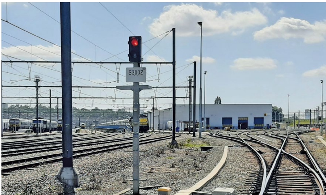
Bild 2: Vereinfachtes Stoppsignal in hoher Bauform
