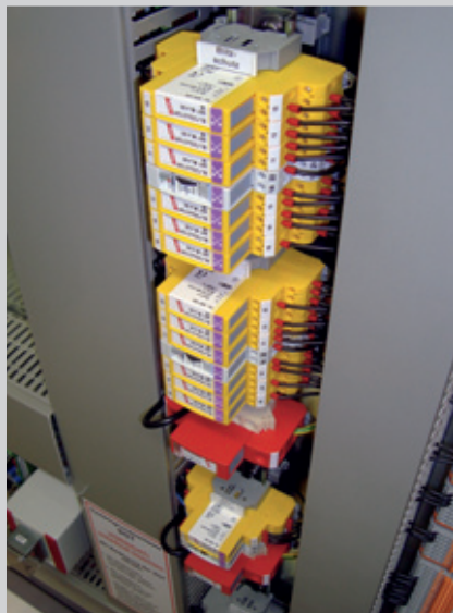
Bild 6: Aufbau Blitzschutz auf KAG der BÜSA
